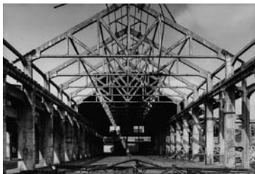
Fig. 1 - Fabbricato industriale dismesso in fase di demolizione; Milano, area Portello anni ,90. Fotografia di architettura © archivio Federico Brunetti
