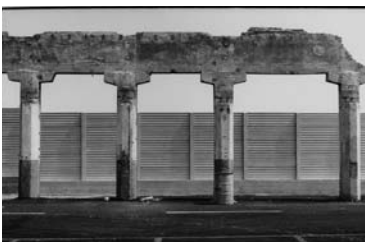
Fig. 2- Visual description of dismantled industrial areas in the archaeology of their architecture. Dettaglio costruttivo di fabbricato industriale dismesso in fase di demolizione; Milano, area Portello anni ,90. Fotografia di architettura © archivio Federico Brunetti
