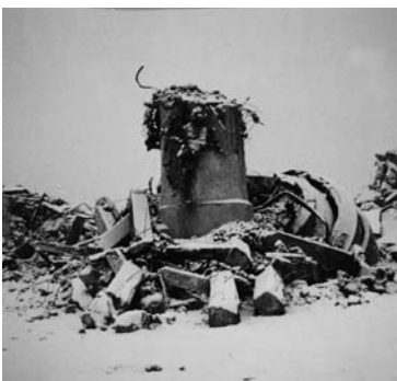
Fig. 3 - Demolitions. Complesso industriale dismesso in fase di demolizione, ciminiera e serbatoio implosi. Milano, area Bovisa; anni ,80; Fotografia di architettura © archivio Federico Brunetti
